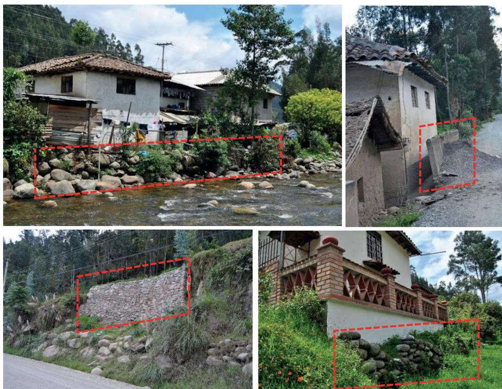
Figura 6: Distintos tipos de muros de contención encontrados en Barabón.
