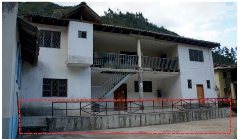
Figura 5: Viviendas elevadas para evitar que el agua ingrese. a. Plataforma de piedras, b. Losa de hormigón armado. Fuente: CG Paute (2011a) y Montaleza (2012). Elaboración: Propia.
