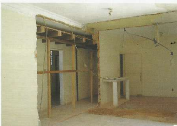
Paredes do imóvel já foram modificadas para a nova disposição das salas
